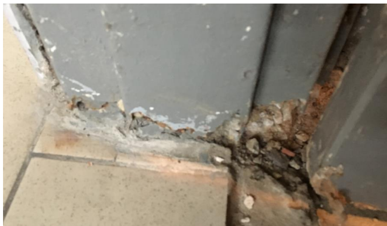
Photo d'une huisserie rongée par la rouille
