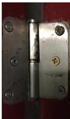
Photo de la situation existante . vis de fixation desserrées.
